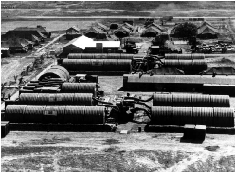
Figura 62 - Unidades portáteis e desmontáveis utilizadas pelo exército americano na Guerra do Vietnã. Unidades infláveis com estruturas rígidas em alumínio. Fonte: www.army.mil Abril, 2011.
