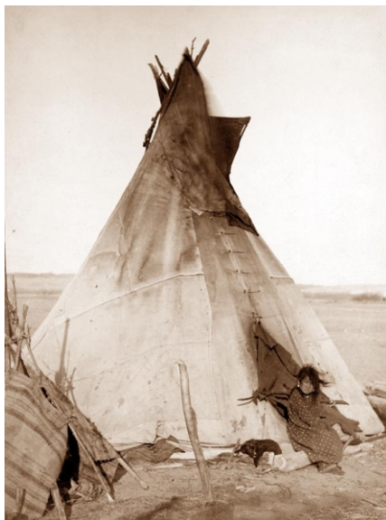
Figura 57 - Tenda TIPI, a estrutura de varas poderia ser erguida em cerca de 5 minutos, e o couro montado em aproximadamente em 15 minutos. Fonte: www.sonofthesouth.net . Abril, 2011.
